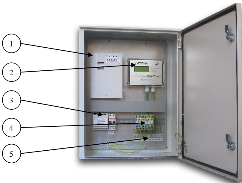
Рисунок 1. Внешний вид и состав комплекса телеметрии ГРП:
